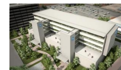
13. GE Planta de General Electric
